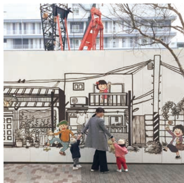
建設中の新長田の県市合同庁舎。周辺エリアでは職員と来庁者による昼間人口の増加が期待されます。さらに子育て世代にも歩いてもらえる魅力をつけたい。
