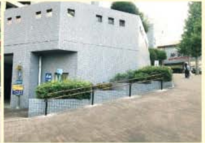
坂道での手すり設置
